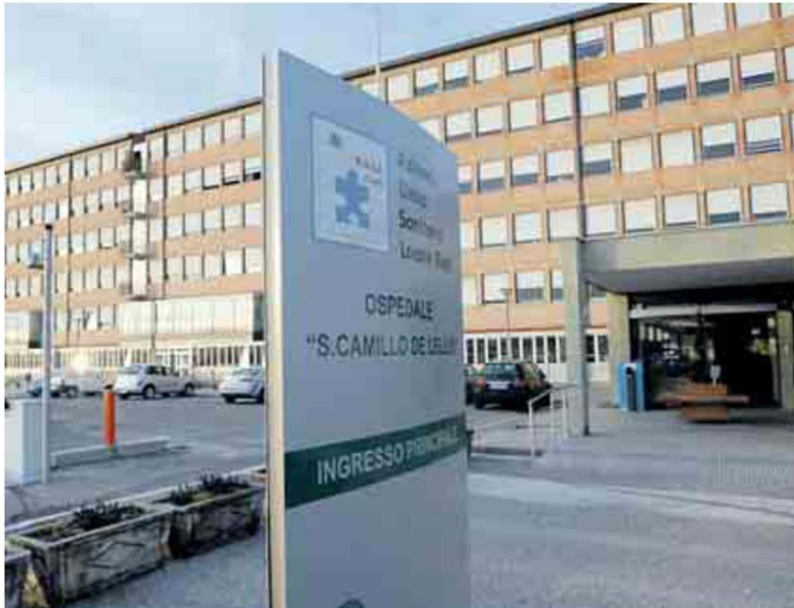
L'OSPEDALE DE LELLIS Il rischio di un declassamento è sempre più concreto
