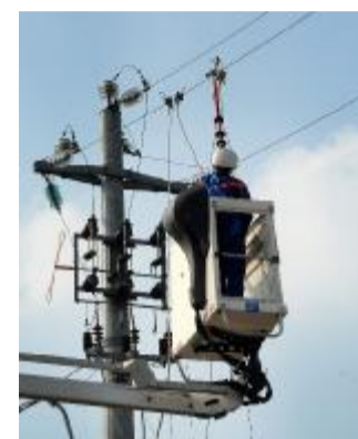
Lavori a un traliccio. ARCHIVIO
