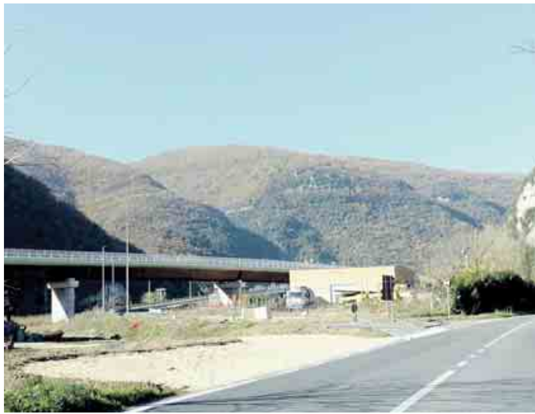
Sopra e a sinistra, due tratti della Rieti-Torano, la cui inaugurazione è in programma per oggi
